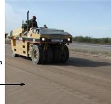
Sellado y terminación final de suelo cemento con rodillo neumático
