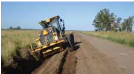
Imagen N° 1 - Reconstrucción con extracción lateral
