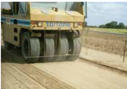
Imagen N° 30 –Compactación con rodillo neumático
