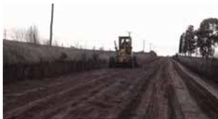
Imagen N° 2 - Perfilado con extracción lateral
