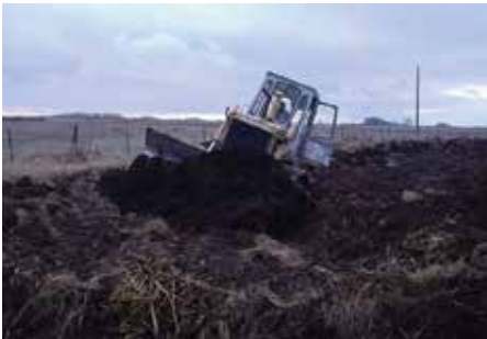
Imagen N° 4 - Alteo con extracción lateral
