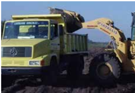
Imagen N° 5 - Alteo con transporte de suelo
