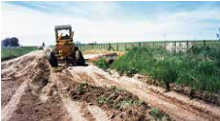
Imagen N° 7 - Conformación de perfil adecuado
