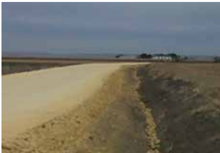
Imagen N° 14 - Cuenta de desagüe longitudinal
