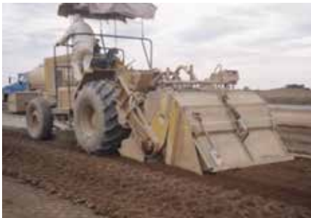
Imagen N° 27 –Mezclado in situ
