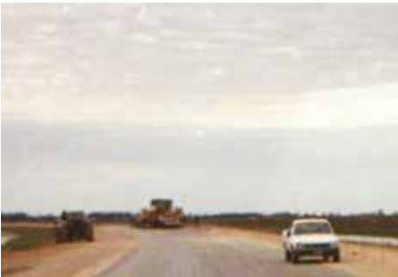
Imagen N° 31 – Superficie terminada cubierta con riego asfáltico
