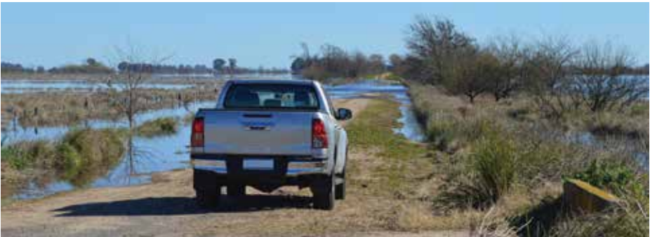
Imagen N° 3 - Falta de un perfil adecuado
