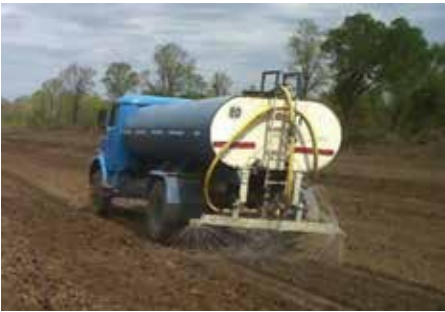
Imagen N° 25 –Regado del suelo con camión cisterna
