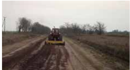
Imagen N° 3 - Perfilado sin extracción lateral
