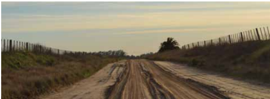
Imagen N° 6 - Perfil de camino en desmonte
