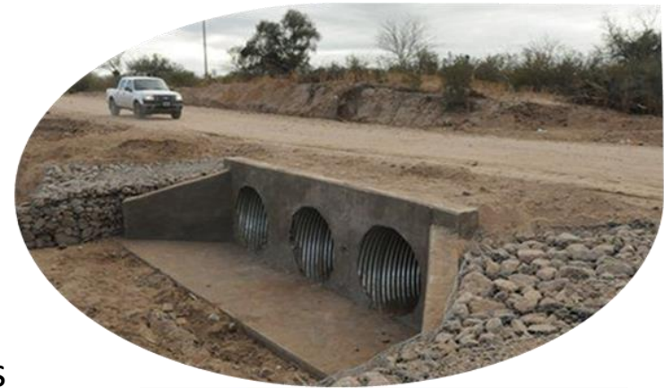
Alcantarilla transversal de sección múltiple
