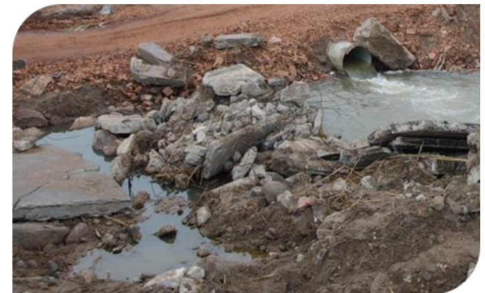
Alcantarilla con alto proceso de erosión
