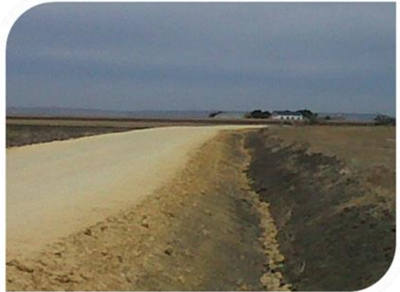
Cuneta de desagüe longitudinal
