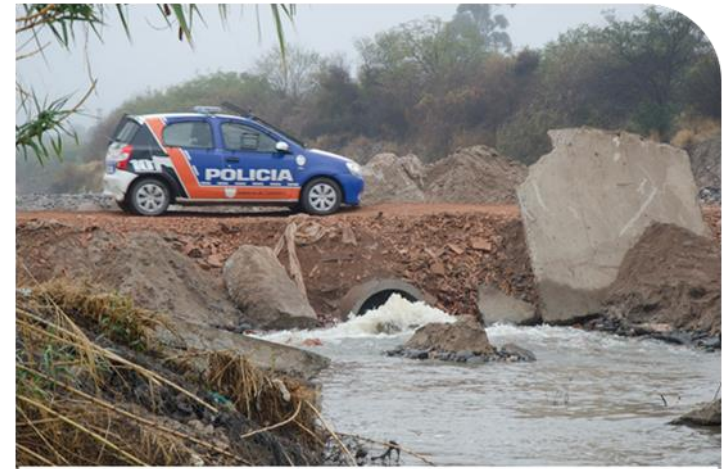
Alcantarilla transversal con fuerte erosión en taludes de cabecera
