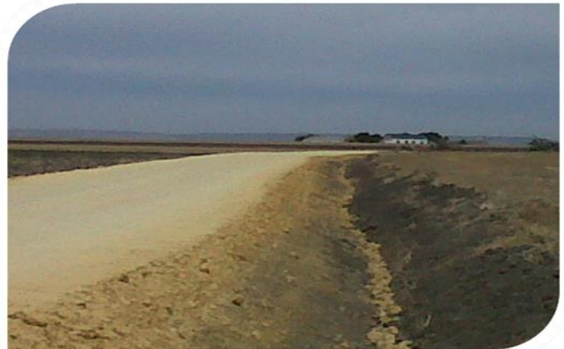
Cuneta de desagüe longitudinal
